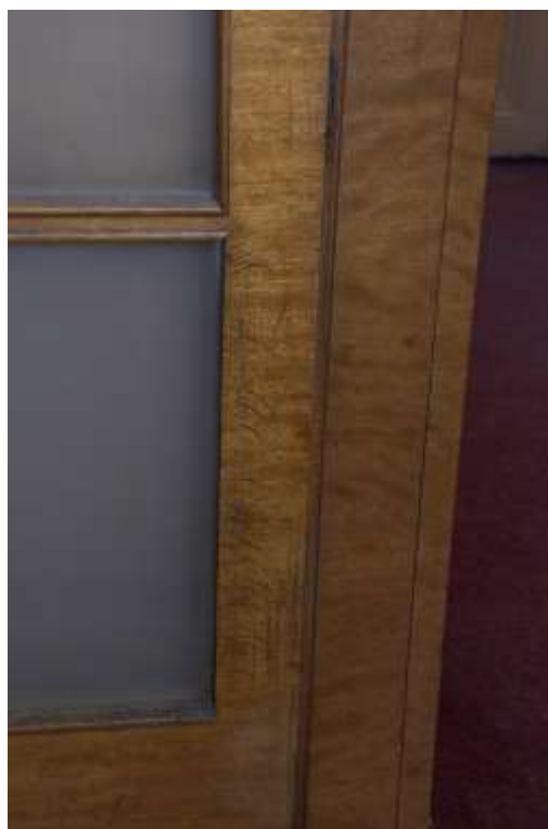
Detail poškozené dýhy dveří (strana od šatny)
