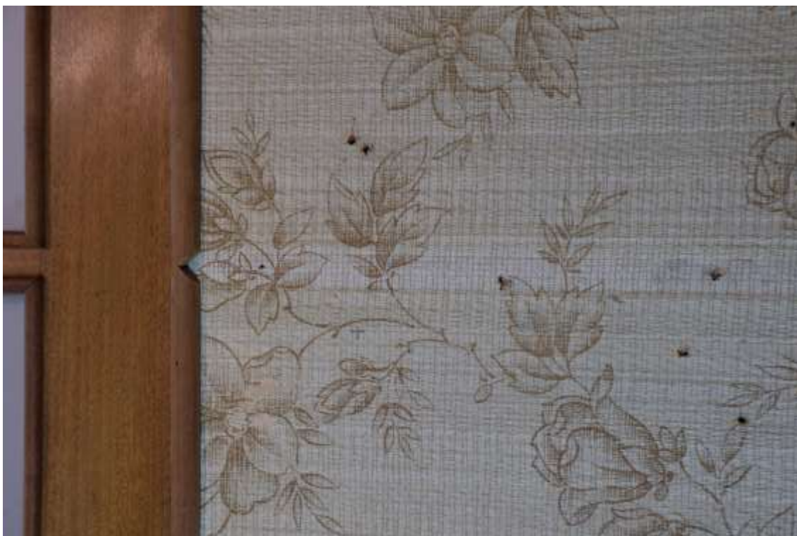
Detail chybějící lišty na přiče
