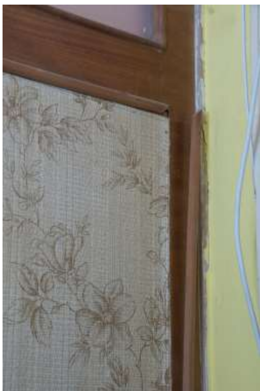
Detail uvolněné lišty na příčce
